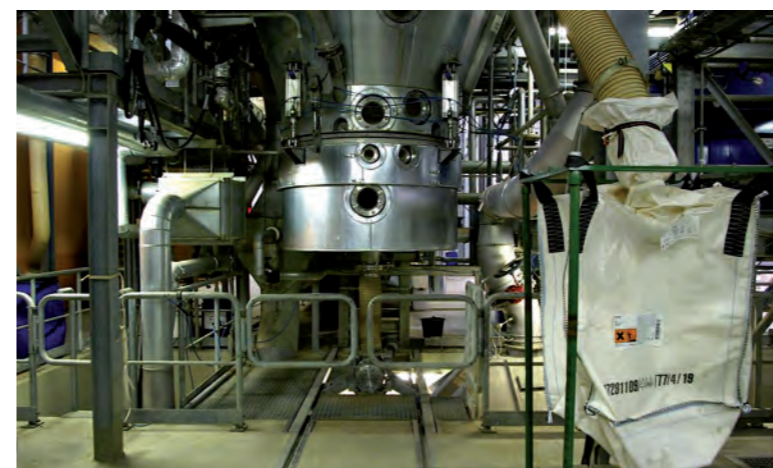
Eine Wirbelschichtanlage zur Herstellung von Granulaten.
