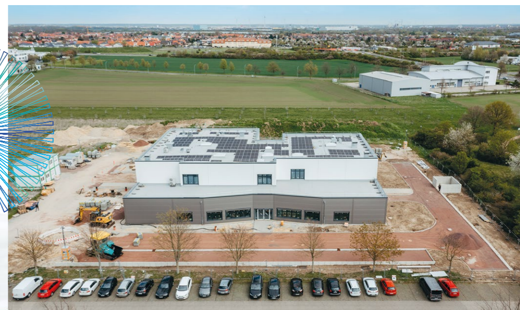
Neubau des Center Method Development in Barleben Foto: Jana Dünnhaupt
